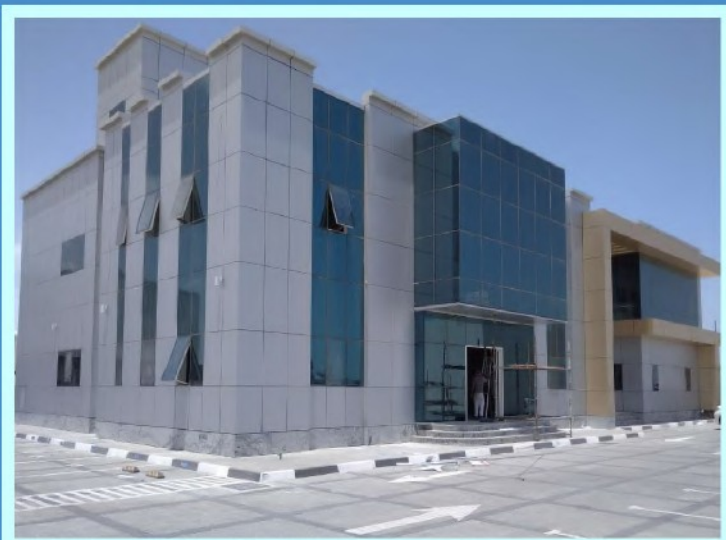
区：M38MUSAFFAH COM楼宇 范围：供应及安装 外部ACP包层&玻璃幕墙
