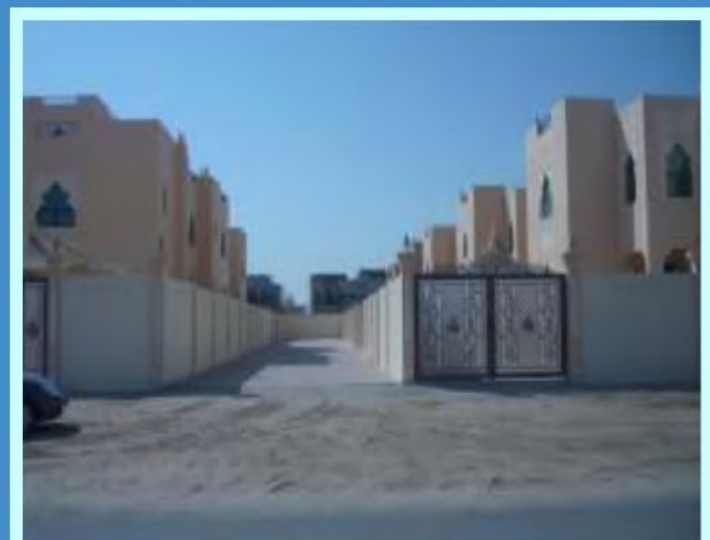
区：12别墅复合MBZ城市范围：供应和安 装玻璃门窗，手栏杆
